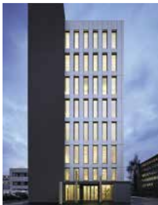
Der LCT ONE in Dornbirn besticht durch seine ressourcenschonende Holz-Modulbauweise.
